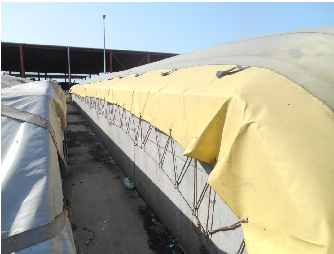
Zdjęcie nr 3 - Oczka stalowe, mocowanie membrany w części bocznej
